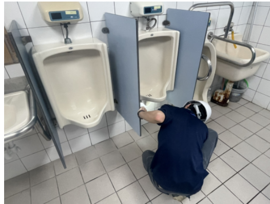
巡檢衛生器具更換劣化止水墊圈，避免滲漏。
