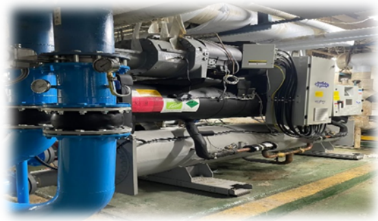
圖 2.2.4、空調系統 332RT 變頻螺旋式冰機
